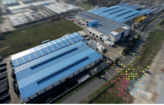
Georg Fischer Hakan Plastik Çerkezköy Üretim Tesisleri
